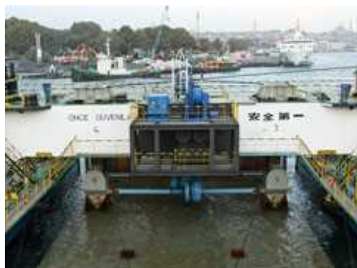
作業船(双胴船)で函体を海底に沈める。手前が函体
